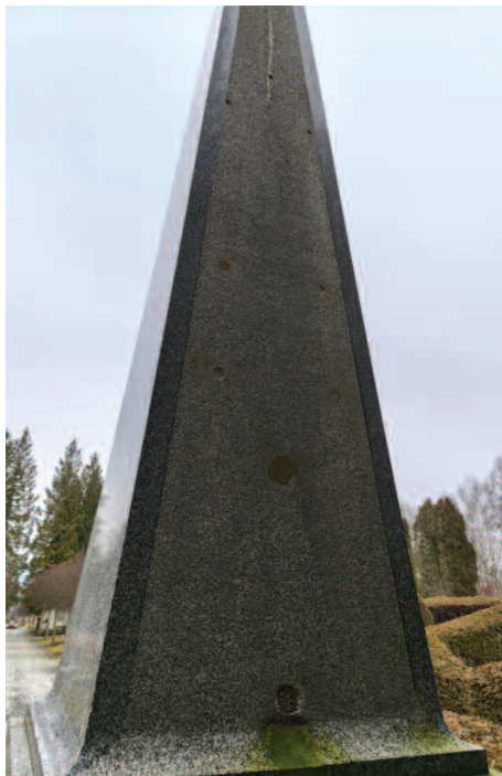
Obelisk byl otočen o 180 stupňů – na zadní straně objevíme kotvící otvory původních kovových doplňků čelní strany. Foto autor
