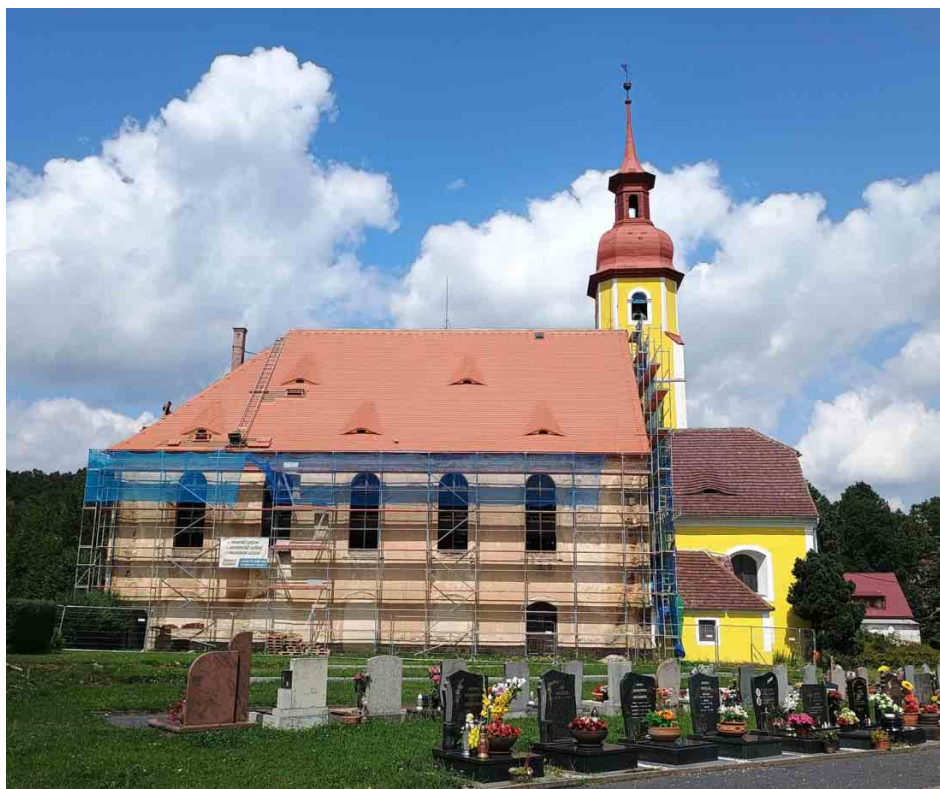
Kostel ve Višňové pokrylo na jaře 2024 lešení. Foto David Benda
