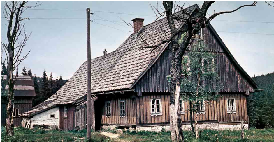
Bývalý Klugeho dům na Jizerce a pozdější terénní stanice Severočeského muzea v Liberci. Pod jeho střechou, na fotografii ještě šindelovou, vznikaly kapitoly Knihy o Jizerských horách .
