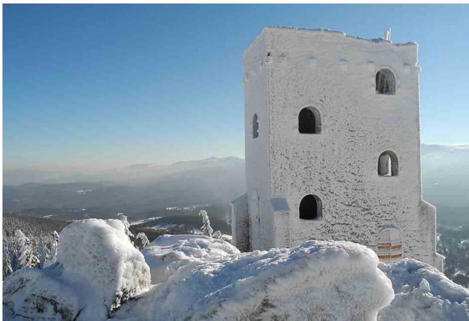
Nedokončená rozhledna v lednovém hávu v roce 2019. Foto autor
