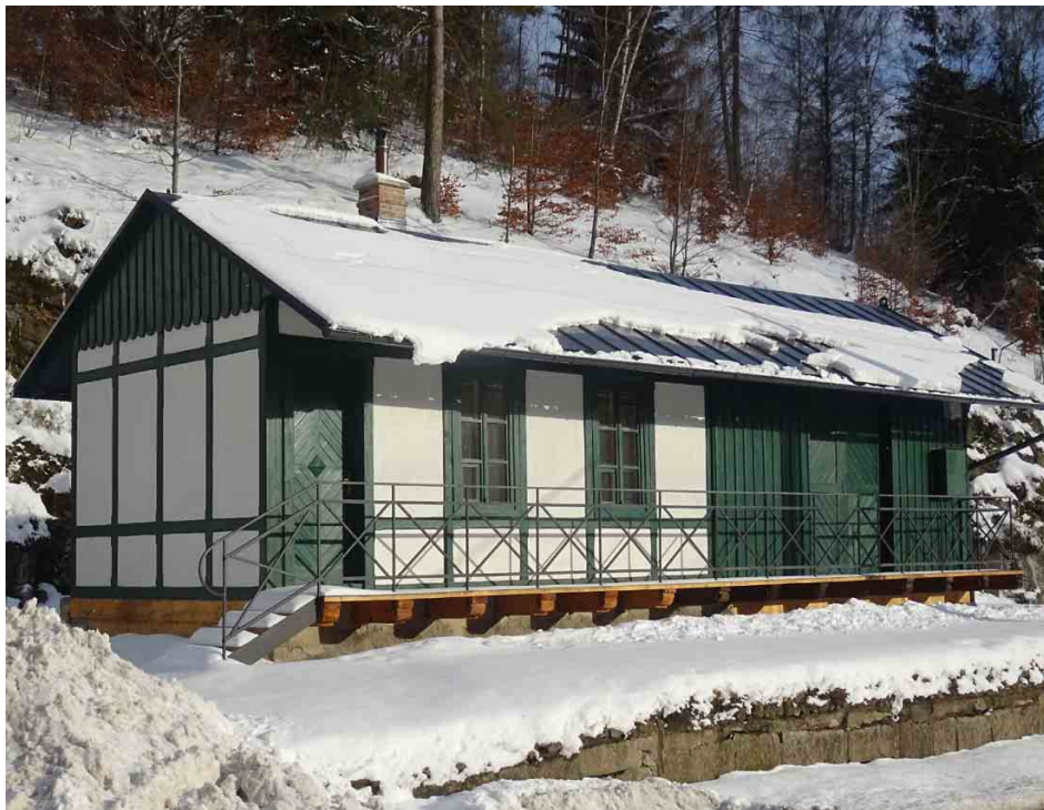
Budova překladiště v Janově nad Nisou. Foto autor
