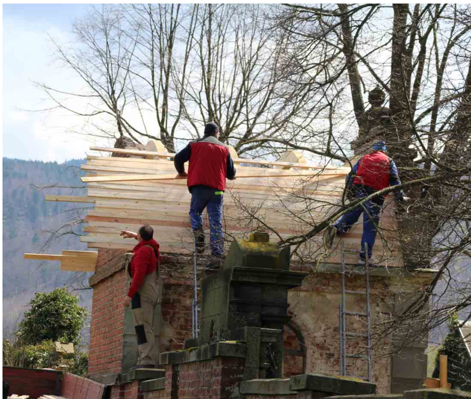
Obnova poškozené střechy byla pro úspěch celého projektu zásadní. Archiv spolku Živo v Hájích
