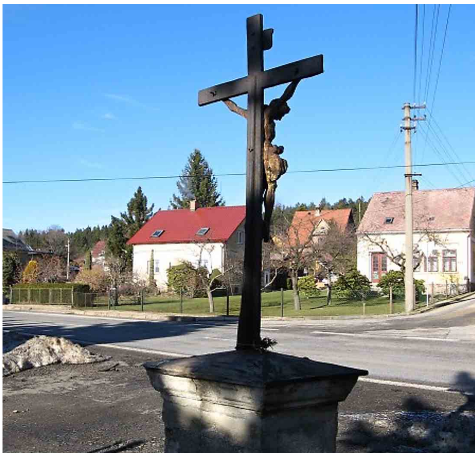
Stav kříže před obnovou, s betonovým podstavcem. Archiv Okrašlovacího spolku NMPŠ
