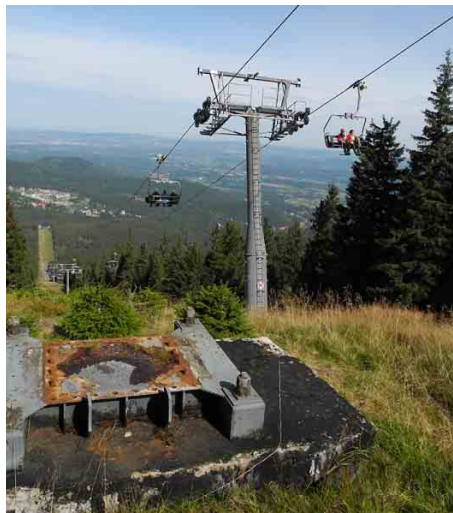
Podpěra sedačkové lanovky č. 14, v popředí zbytek podpěry č. 19, foto Otokar Simm
