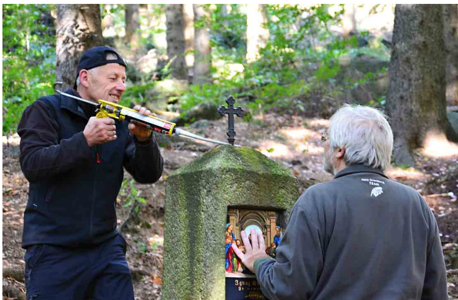
Pomocí chemické kotvy byla upevněna nová deska a zpevněn křížek na vrcholku, foto František Golis
