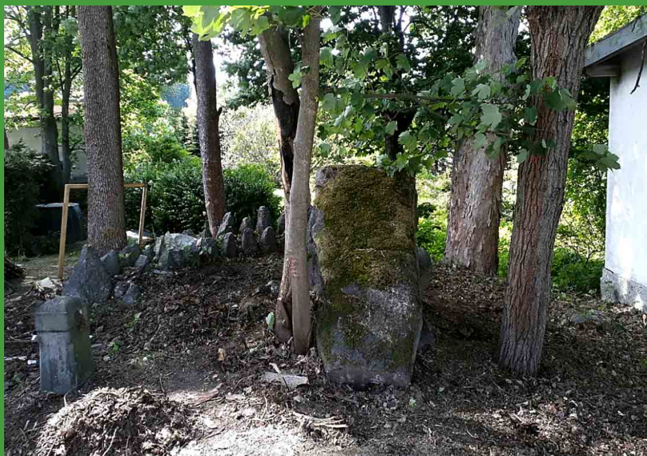
Torzo Jahnova pomníku před započítím opravných prací, foto Oliver Scholze
