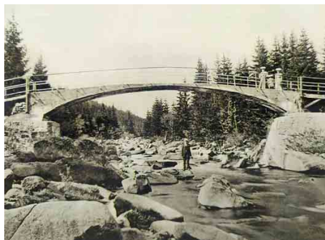
Nový železobetonový most byl v roce 1901 chloubou tehdejšího stavitelství a průkopnickým řešením výstavby silnic ve Slezsku.
