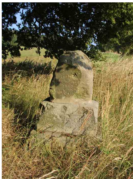
Těžce poškozený pískovcový podstavec kříže Josefa Herziga
