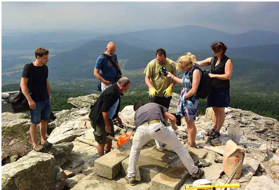
Úprava základů pod Rohanským kamenem na Ještědu, foto Pavel Schneider
