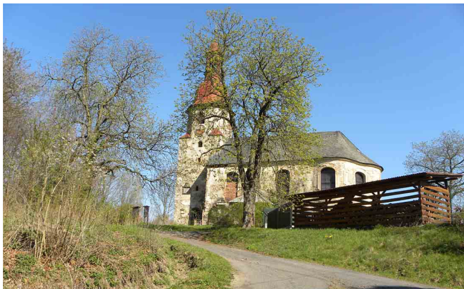
Kostel v Horním Vítkově po určitou dobu sloužil i jako sklad nábytku
