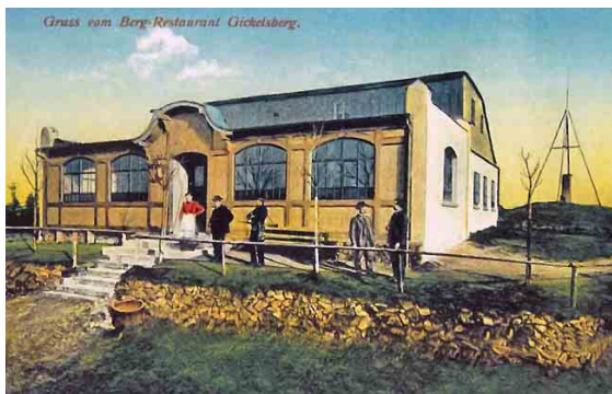
Po bývalé restauraci zbyly jen zbytky základů
