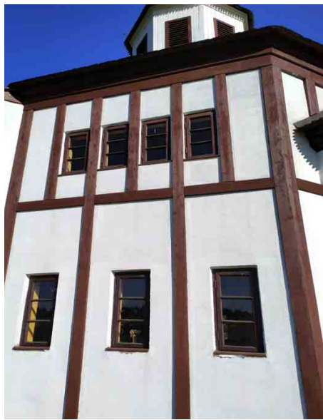
Architekt použil pro Jizerské hory netypickou techniku hrázdění
