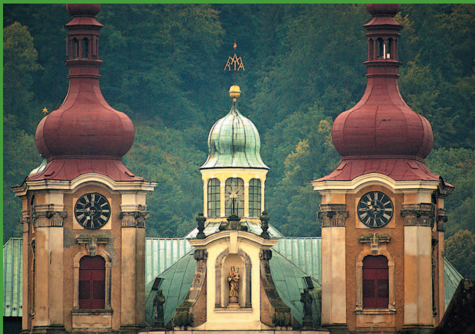
Věže kostela v Hejnicích před opravou průčelí v roce 2008, foto Bohumil Horáček
