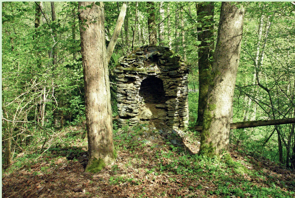
Wallerova kaple, stav před opravou (2016), foto Jan Suchánek
