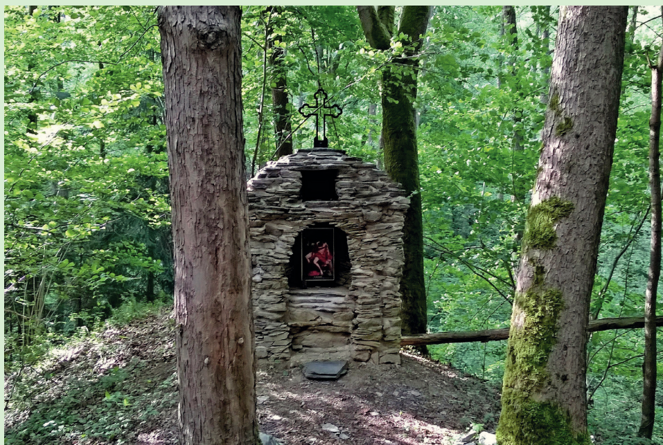
Opravená Wallerova kaple v červnu 2017, foto Bohumil Horáček
