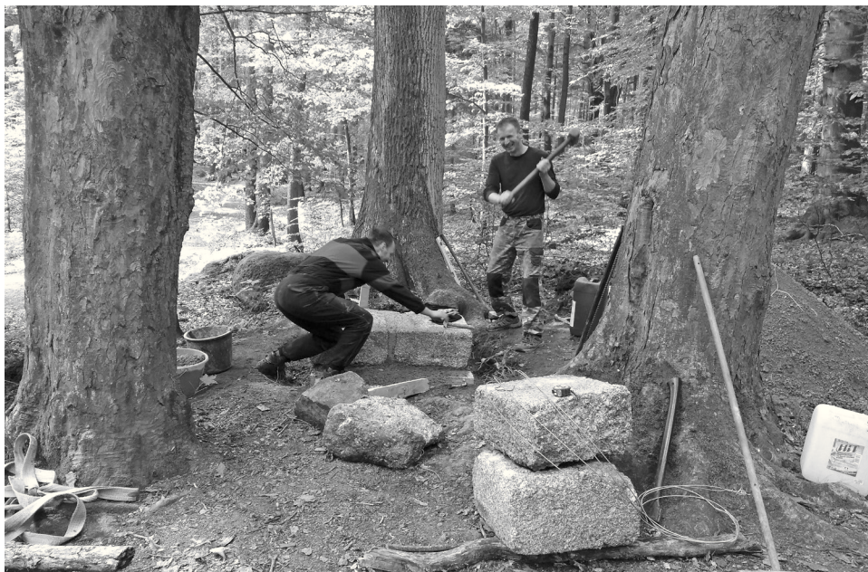
Budování nového základu památky při Staré poutní cestě
