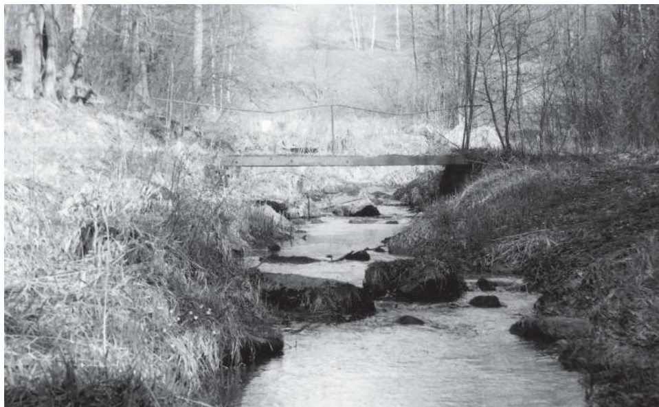
Chatrný mostek přes Kočičí potok
