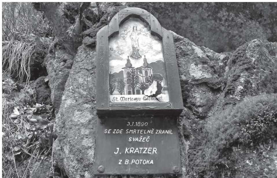
Stav obrázku na začátku května 2016 – před opravou, foto Bohumil Horáček
