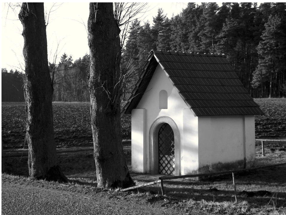
Kaplička severně nad obcí Bílá stojí na rozcestí silnic.
