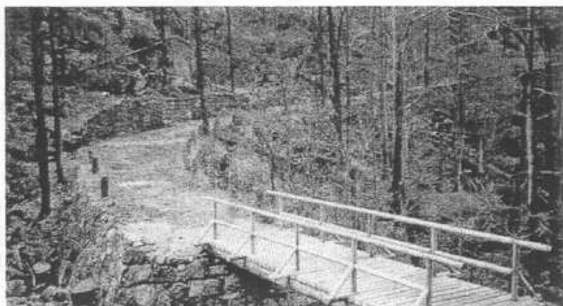
Nově postavený most pod vodopádem Velkého Štolpichu včetně opravené levobřežní opěry
